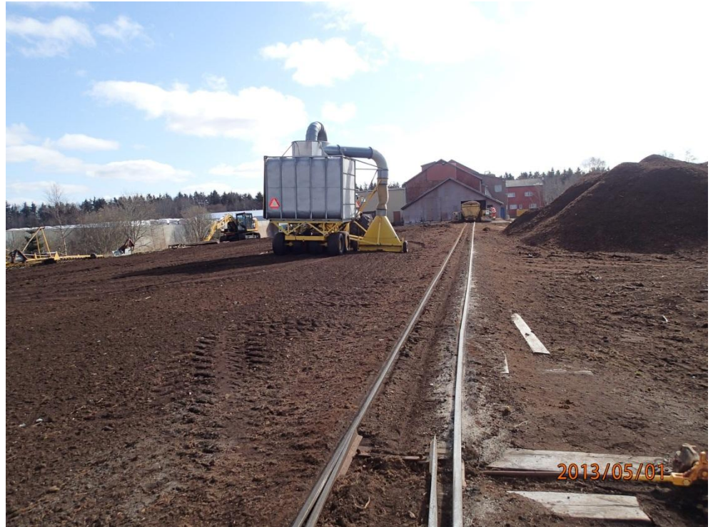
Figur 4-7 Tørvebanens indkørsel til fabrikken
