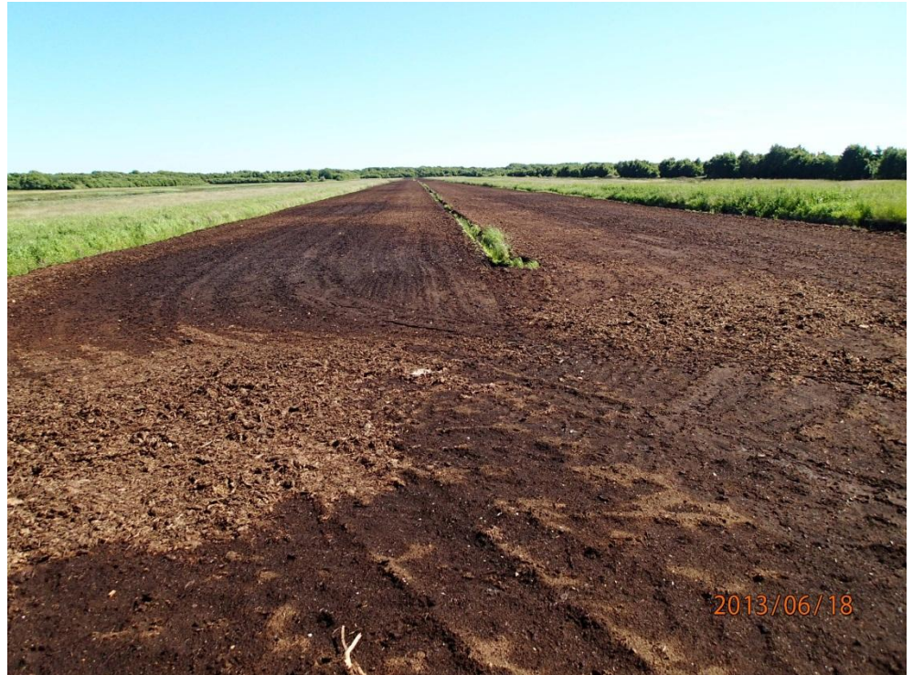
Figur 9-4 Foto af det sydligste delområde, 87a, hvor kanten af det græsbevoksede areal består af tilsået, afgrømmet overjord. Denne kant er med i projektområdet. Bemærk store mængder af "hundekød", delvist nedbrudte rester af rødder eller tuer fra tidligere vegetation (f.eks. tuekæruld) i kær-, sump- eller skovtørven.
