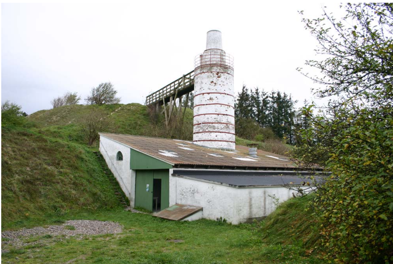
Selve bygningen med ovnen er bygget ind i skrænten. Morten Pedersen 2006.
