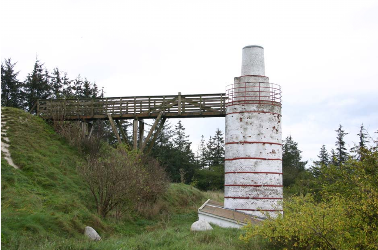
Ovnen er placeret neden for skrænten, så det var let at køre kalken hen til tårnet, hvor den blev knust i mindre stykker inden brændingen. Morten Pedersen 2006.
